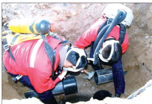
破损管道快速修复。
