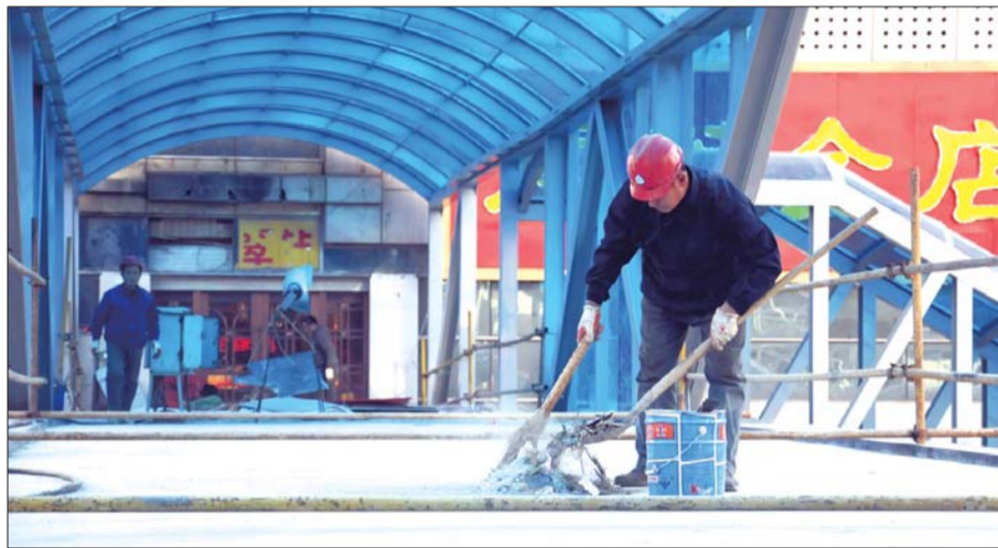
2日,天桥改造工程施工两个多月,目前已开始加盖PC耐力板。 本报记者 韩逸 摄
