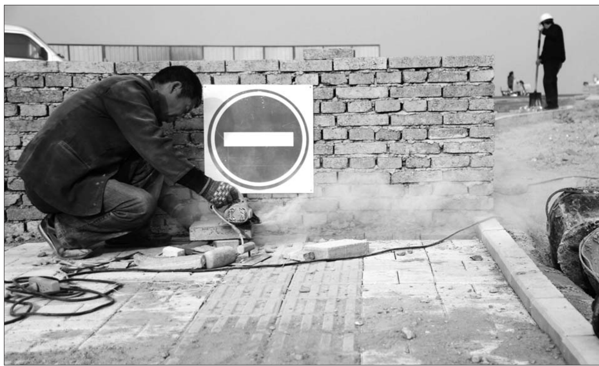
12月2日,减河、岔河两岸堤顶路的新建和改造工程目前已基本完工。此项工程计划投资8000万元,计划完成减河、岔河河堤两岸路面施工58公里的堤顶路新建和改造。目前,受滨水路修建的影响,岔河还剩2公里的路段才能完工。
