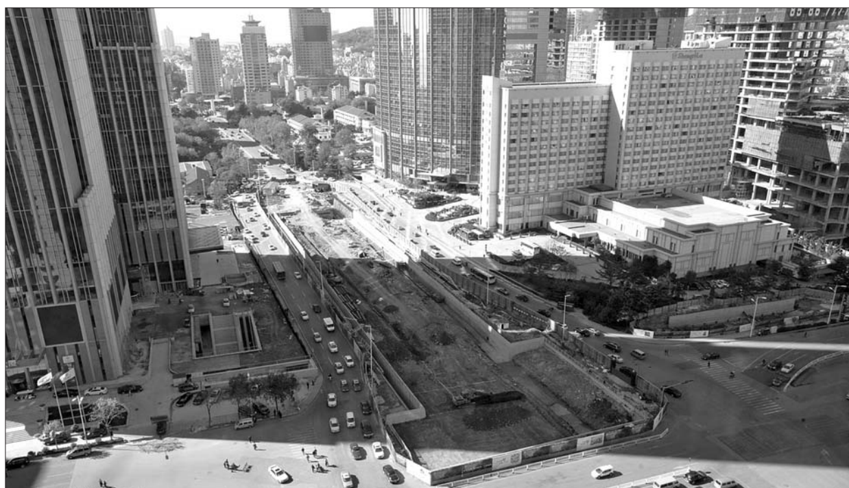
青岛地铁3号线五四广场站正在建设中。 本报记者 张晓鹏 摄
