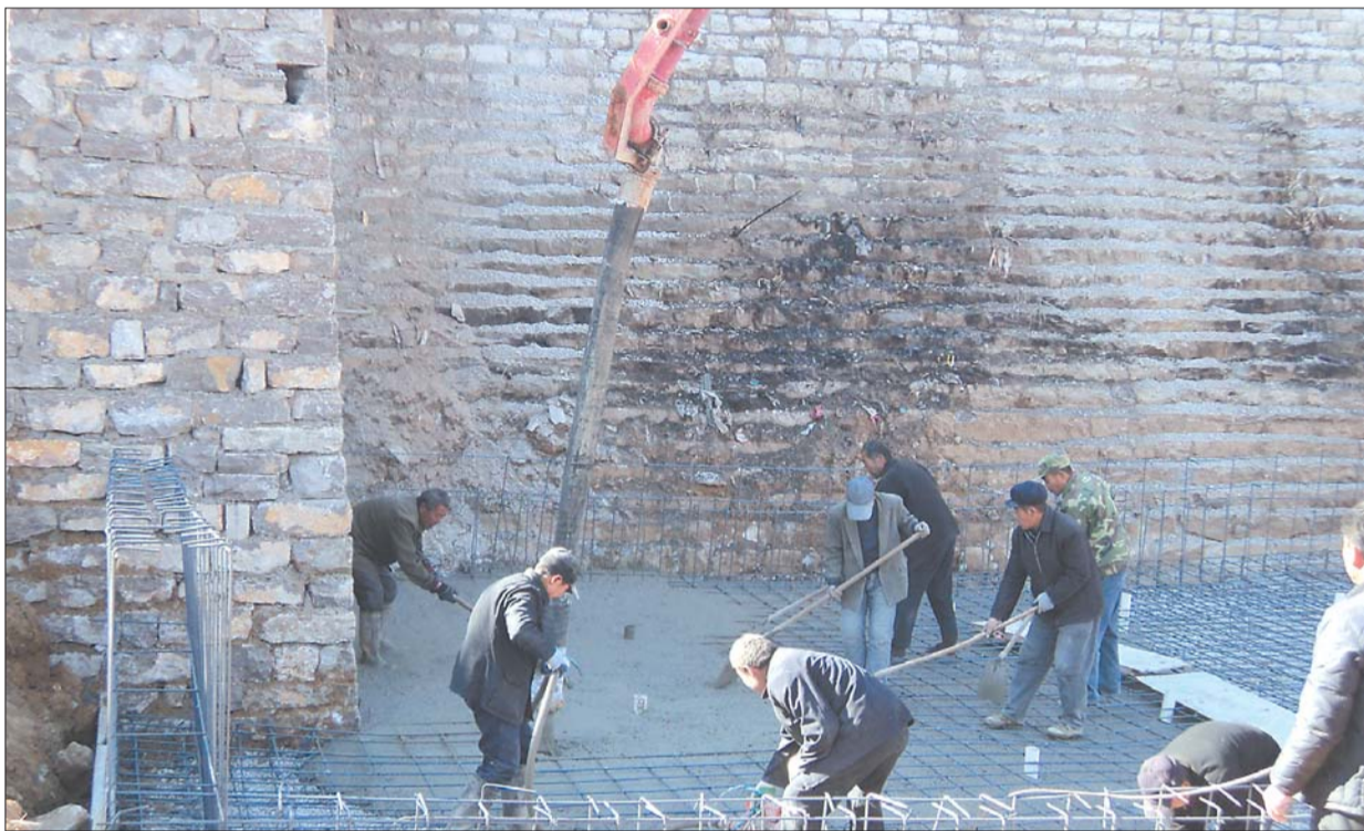
近日,长清区归德镇今冬实施的水利工程安全项目在如火如荼地进行,该项目总投资204万元,实施了永平村、东赵村、南郑村、山贾庄等五座塘坝项目的防汛除险加固。工程从11月10日全部开工,现已完成工程总量的70%,12月底,项目将全部竣工。该项目的实施,将进一步提升水利工程安全,改进所在村庄的环境。图为民工正在修建塘坝坝坡。
