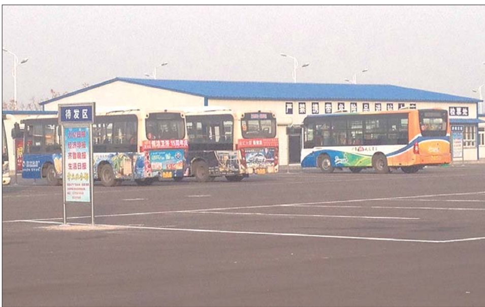
即将启用的章丘临时客运站。 本报见习记者 赵克 摄
