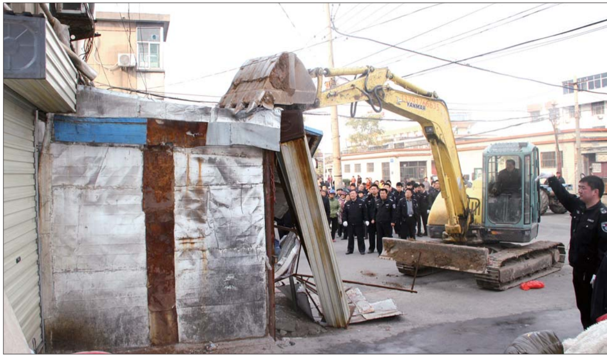
执法队员正在拆除违章建筑。
