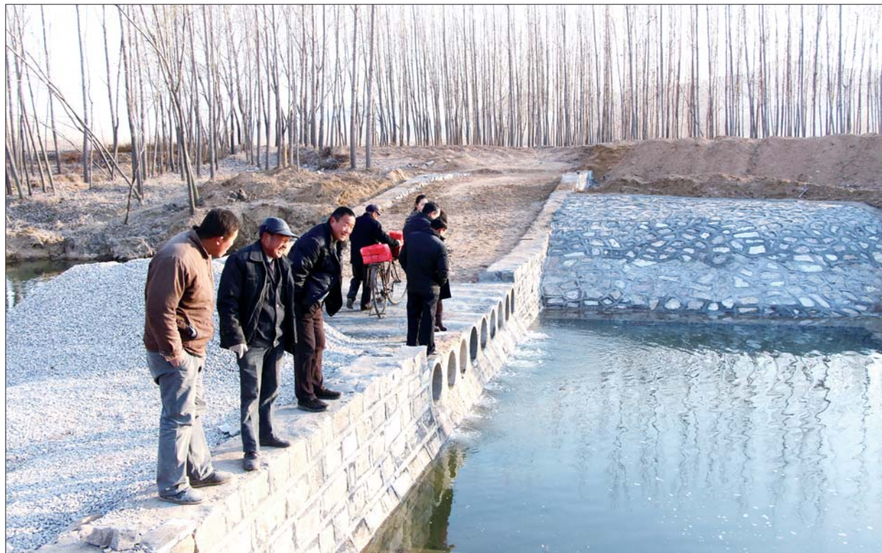
正在建设中的拦水坝。
