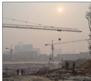
雾霾天气下,工人还在户外施工。 本报记者 侯峰 摄
