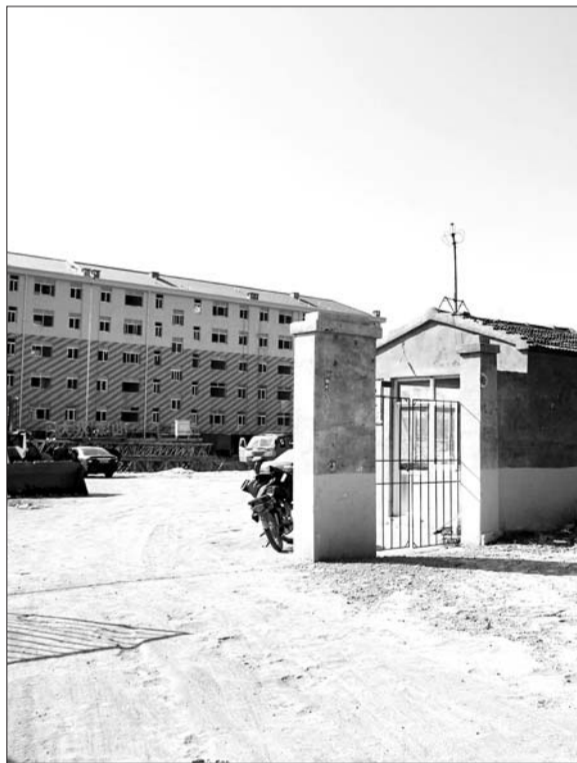
高唐琉璃寺镇营坊千户社区建设,一期建设86户,可容纳附近冯庄村整体拆迁要求,二期建设410户。本报记者 李军 摄
