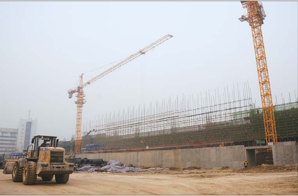
建设中的菏泽火车站。 本报记者 邓兴宇 摄
