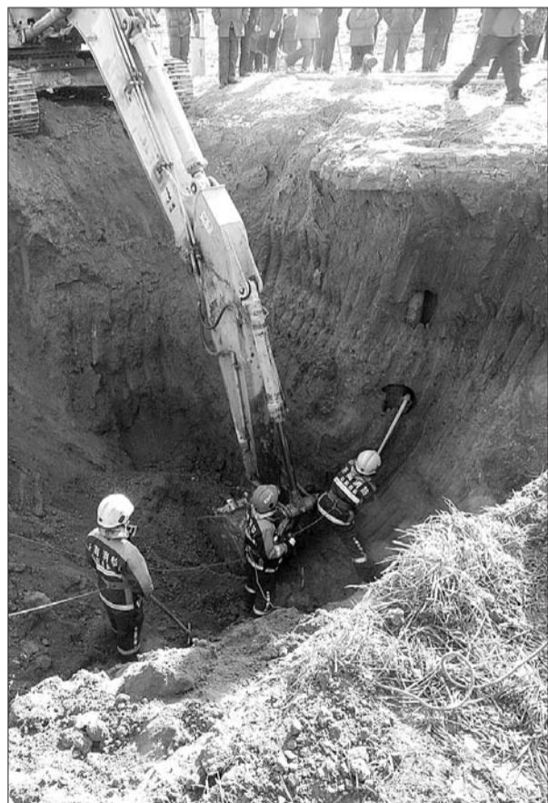
经过挖掘,露出井道,消防官兵开始用双手挖掘。
