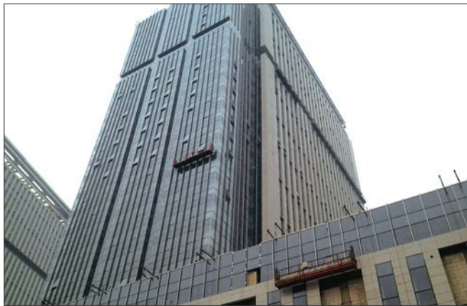
奥盛大厦正在进行外部装修。
