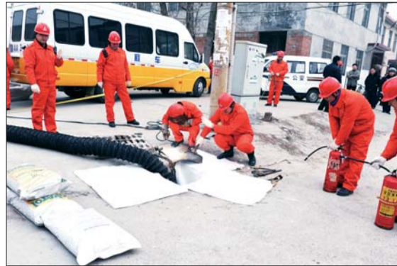
动火“封堵”作业。
