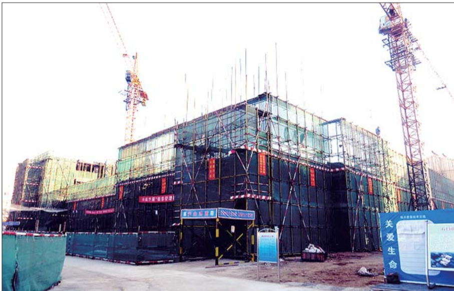
石臼中心小学教学楼施工现场。(资料片)
