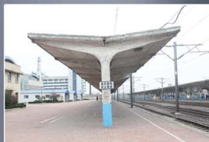
菏泽火车站改造前的站台、雨棚。
