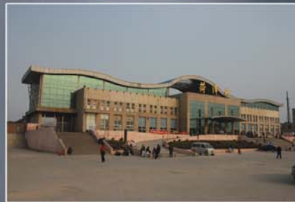
改造前的菏泽火车站站房。
