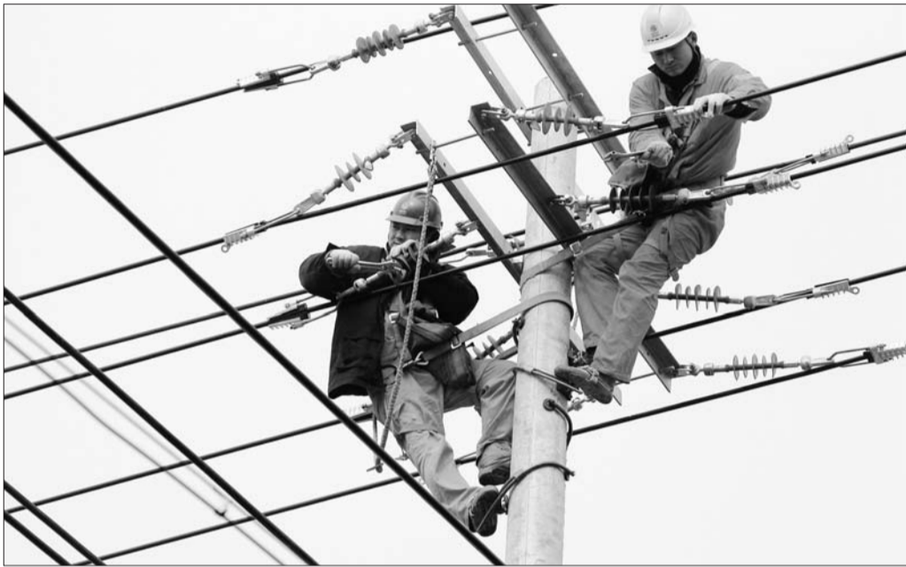
12月29日,枣庄供电公司滕州客服中心员工顶风冒寒对滕州市东沙河镇10kV前梁线、朝阳线、吉山线进行了线路割接施工,使负荷分配更加合理,线路网架联络得到进一步加强。据了解,随着滕州市高铁新区规划建设,一批大项目、好项目纷纷落地,用电需求增长迅猛,为缓解供电压力,滕州客服中心新建4条10千伏线路,并全部完成割接,一次送电成功。(徐同超)
