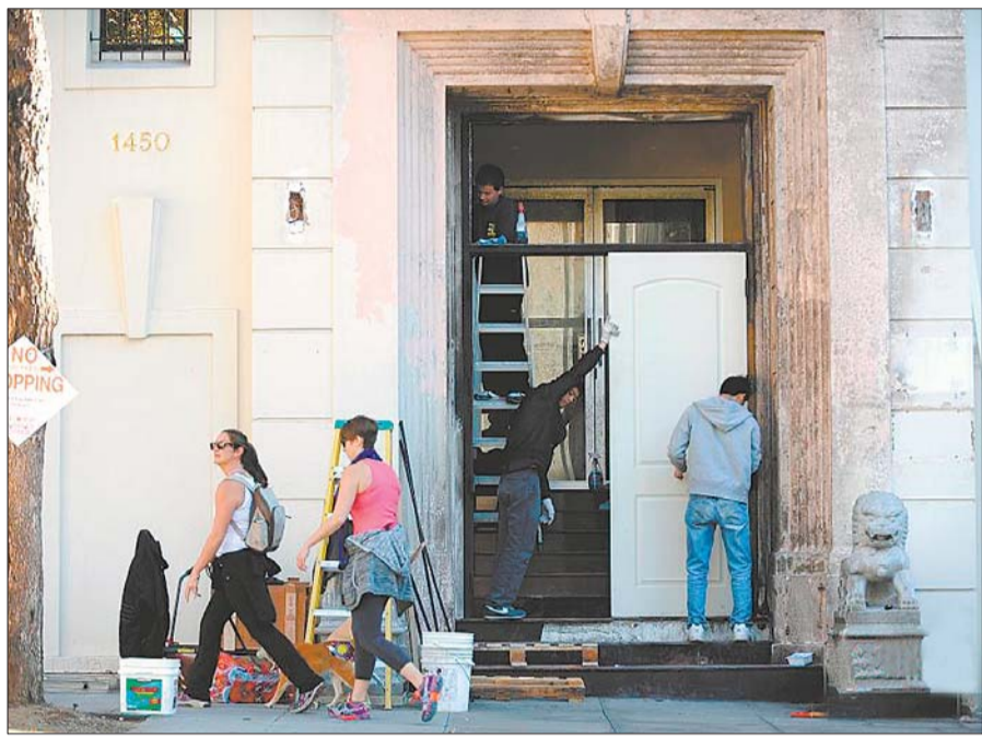
当地时间1月5日,中国驻旧金山总领馆工作人员开始安装临时正门。
