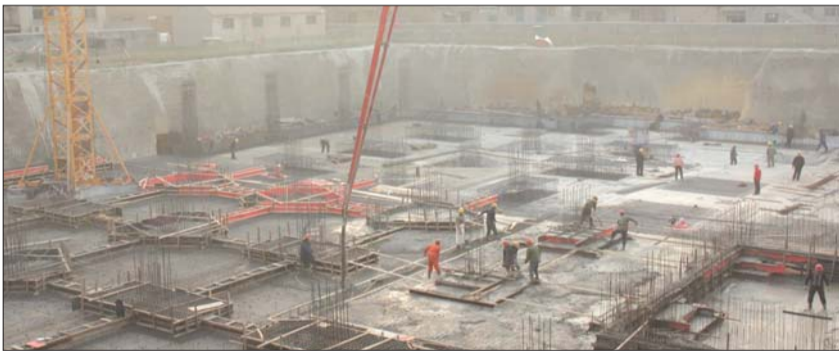
韩家结庄农贸市场正在浇筑混凝土。
