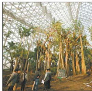
场馆正在进行精装修。 本报记者 张晓鹏 摄
