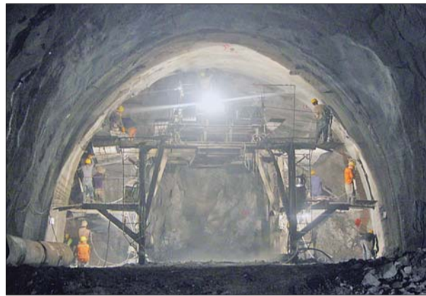
晋豫鲁铁路西铁车二号隧道贯通前,工人在做最后的准备工作。
