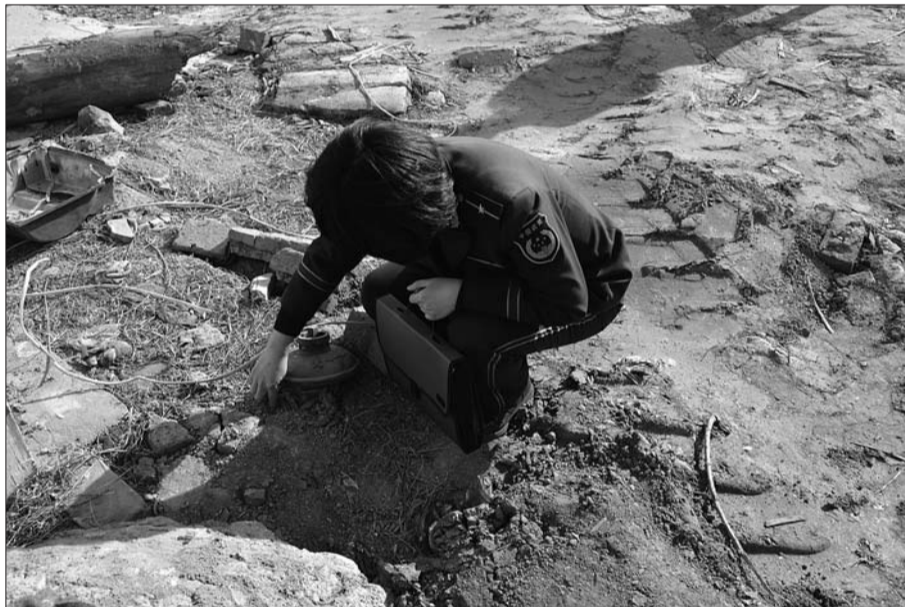
木材厂室外消火栓只有顶尖露在外面。
