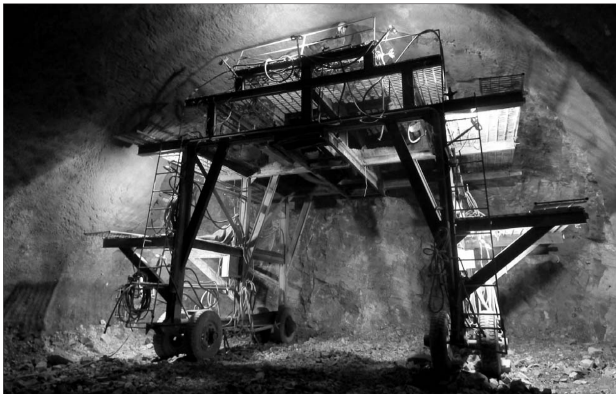
隧道贯通前,施工人员正在开挖台车上作业(资料片)。
