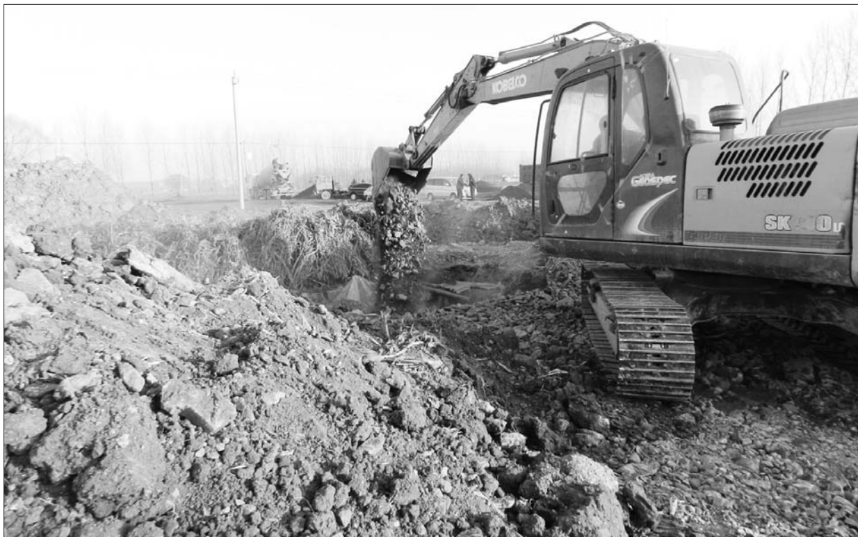
执法人员用混凝土将井口填埋。
