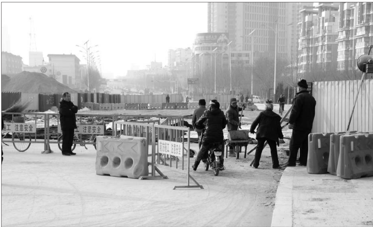
1月23日,在东风路岔河桥上,施工人员正在搭建护栏,不少骑车的市民穿过围挡抢先通行。 本报记者 马志勇 摄
