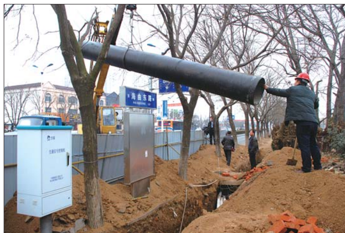
海曲路更新供水管道。 本报通讯员 孟华 摄
