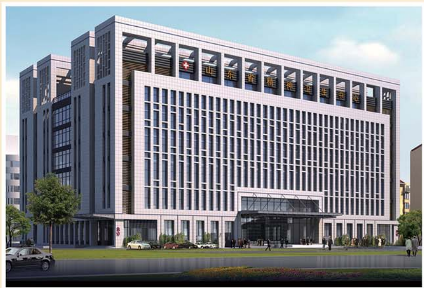
门诊医技综合楼
