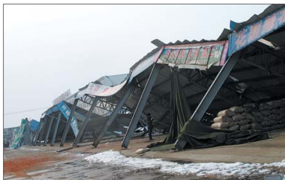
7日,济宁市金乡县大蒜国际市场服务中心内,一万多平方米的钢结构遮阳棚被积雪压塌,近百吨货物和多辆货车被砸。 本报记者 姬生辉 摄
