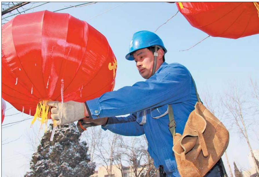
电工师傅对沿路悬挂灯笼接线情况进行检查。
