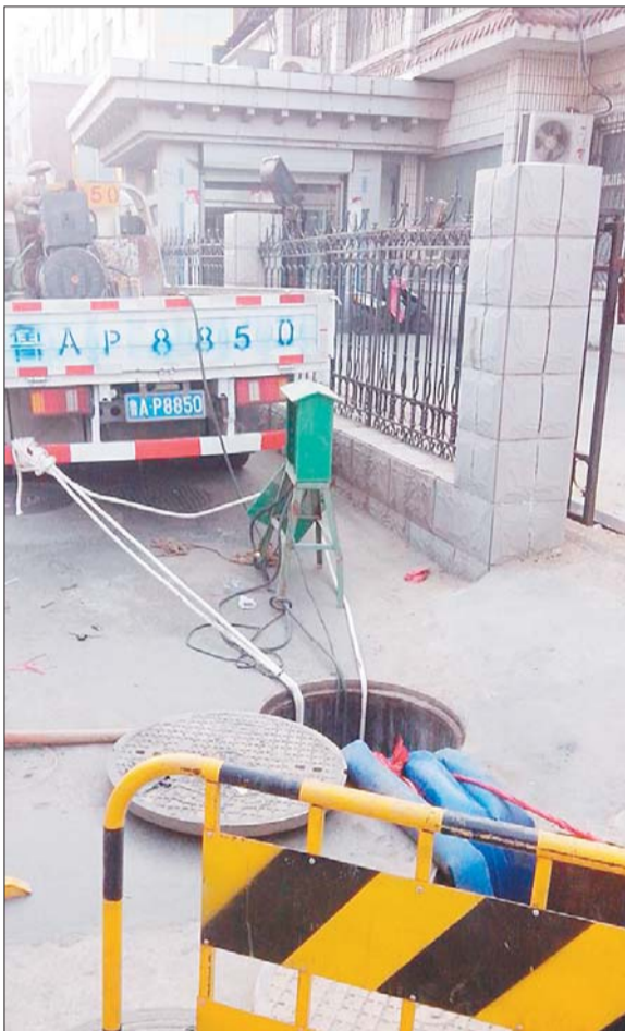
21日,南门桥涵洞闸门关闭后,工作人员将污水用水泵抽到附近的污水管道中。 本报记者 王光营 摄
