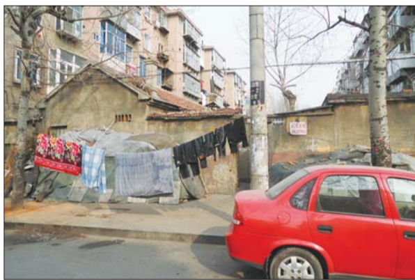
破裂的自来水管压在房子下面。本报记者 王敏 摄
