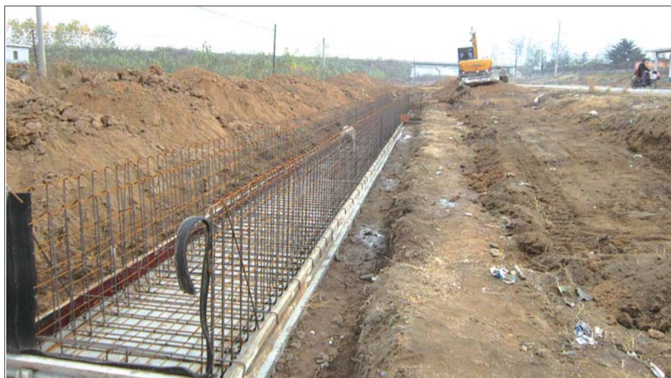
正在施工的天津路改造工程。
