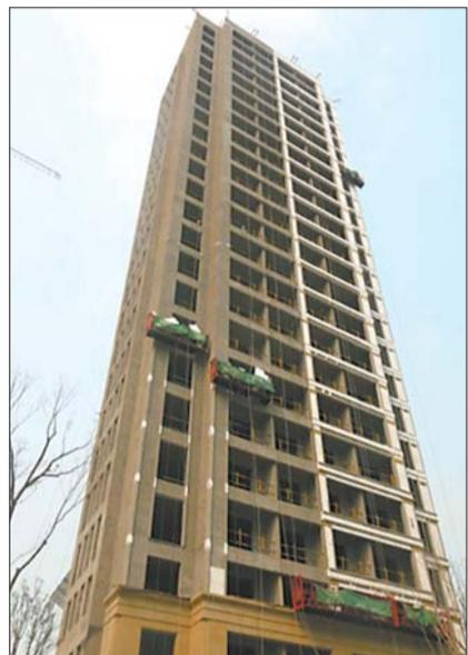
EPS板保温体系是由特种聚合胶泥、EPS板,耐碱玻璃纤维网格布称和饰面材料组成。集保温、防水、防火,装饰功能为一体的新型建筑构造体系。该技术将保温材料置于建筑物外墙外侧,不占用室内空间,保温效果明显,便于设计建筑外形。
