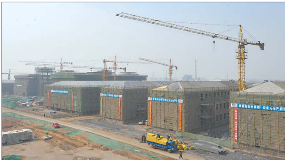
鑫茂科技城建设工地。 通讯员 刘政 摄
