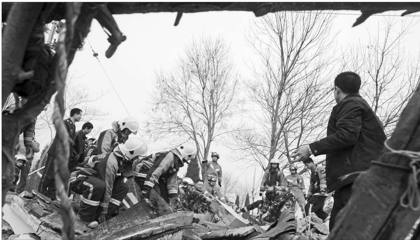
8日下午,在德州,一辆满载石子的大挂车撞倒工厂保安室,三人被埋。图为救援人员用手抬高水泥板,营救被埋人员。 本报记者 马志勇 摄
