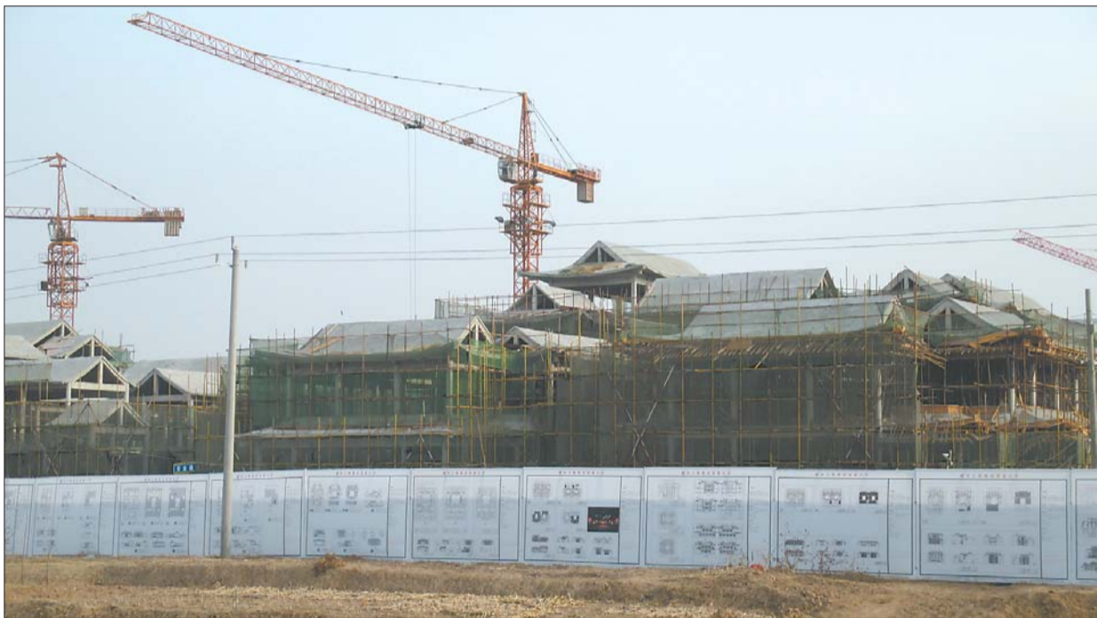
黄河古镇项目施工现场。 记者 梁越 摄
