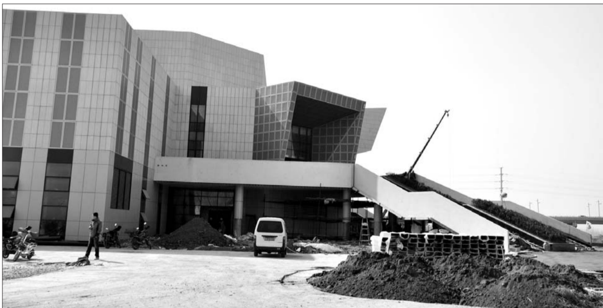
建设中的曲阜市体育馆。本报记者 公素云 摄
