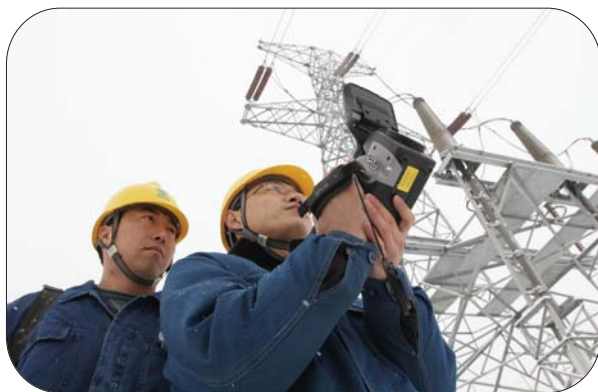
保电人员正在特巡高铁专线220千伏香铁线。 代兆民 摄
