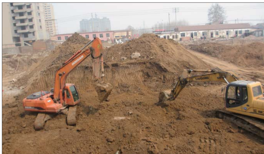
施工车辆正在施工,不远处就是居民楼房。 本报记者 张汝树 摄
