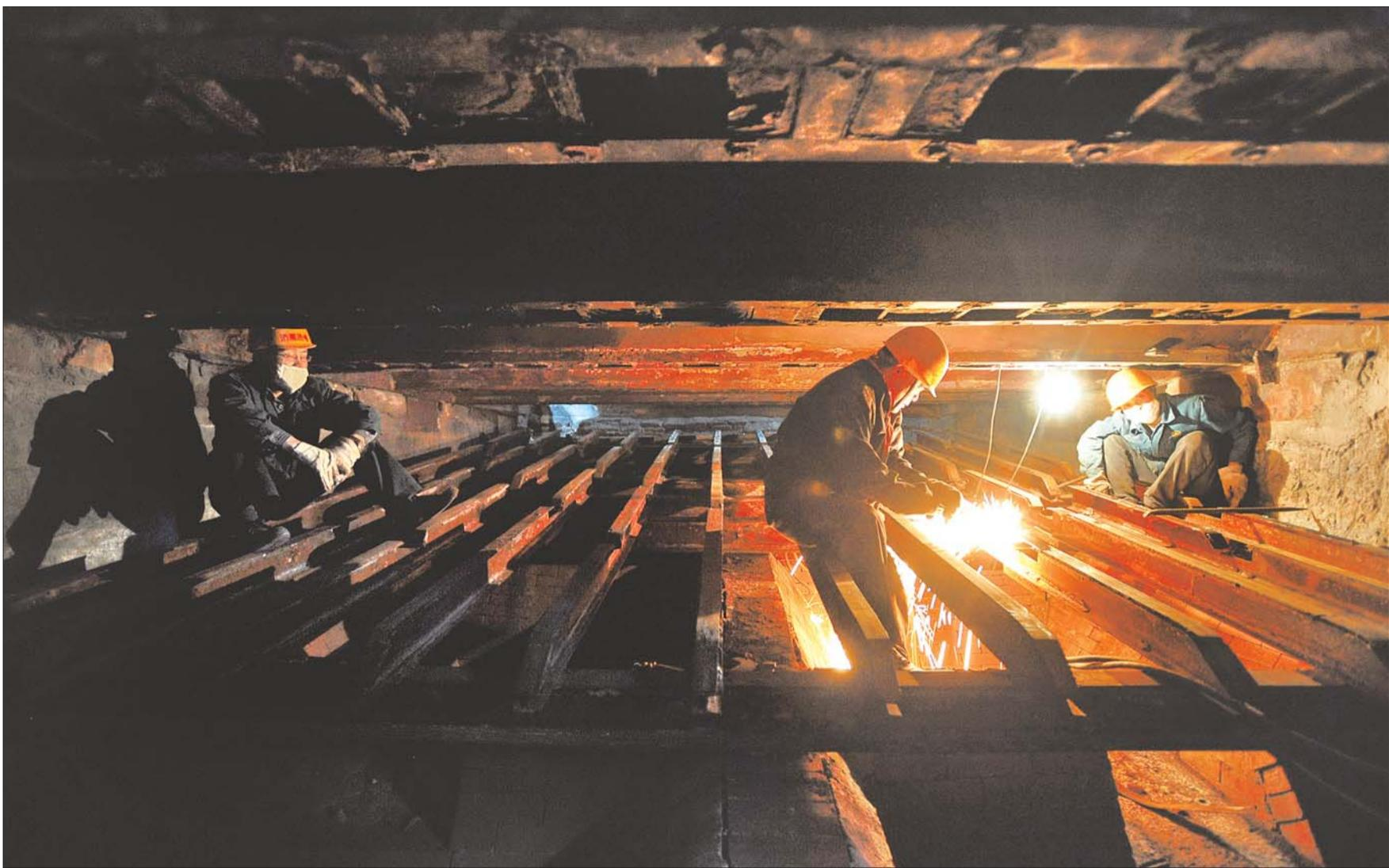
在漆黑闷热的锅炉内,温度达到了40℃—50℃,工人们在维修被高温烧蚀的炉膛部件。
