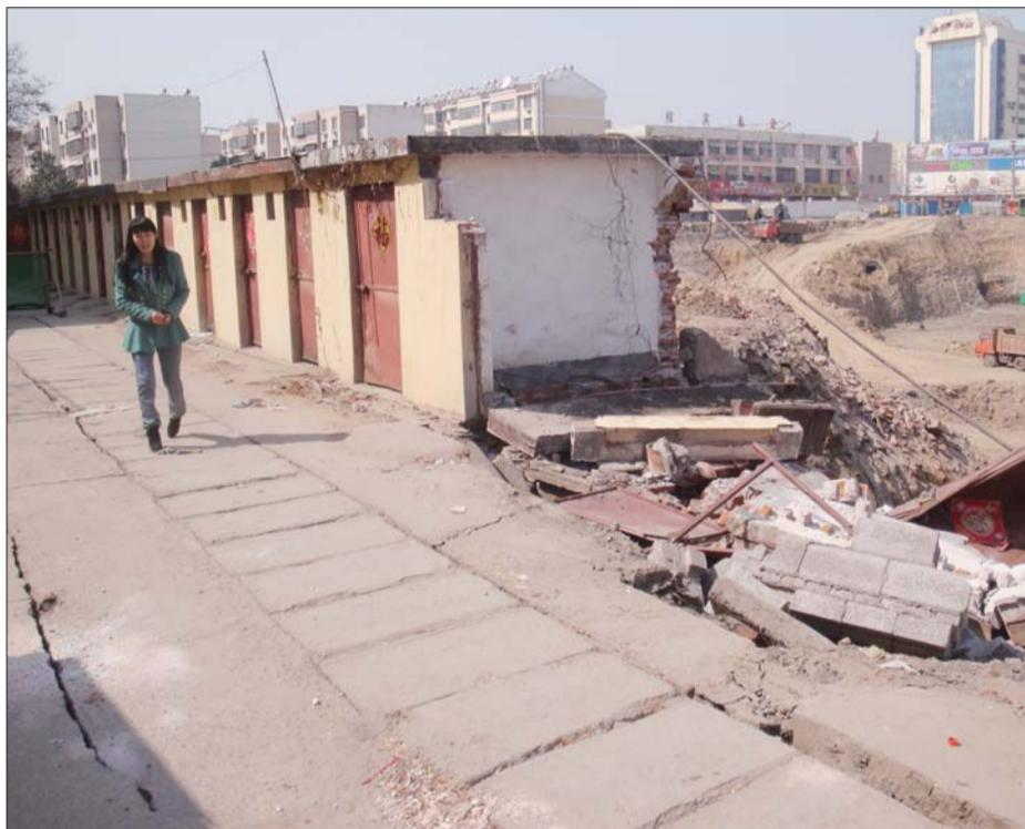
5号楼前面最东面的两间储藏室已经坍塌,储藏室前面的路面也出现裂缝、下陷。 本报记者 杨兵三 贾晓雪 摄
