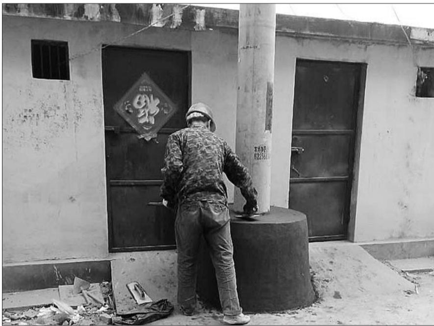
建筑工人正在加固储藏室前面的电线杆。 本报记者 杨兵三 贾晓雪 摄
