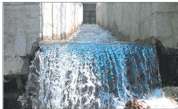
锦绣川水库正在通过输水干渠的排水洞向外排水补给省城地下水。 记者 蒋龙龙 摄
