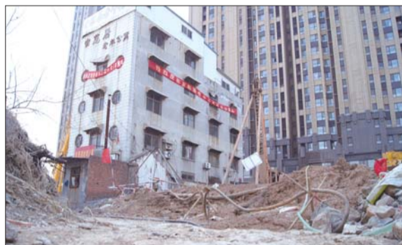
位于拆迁工地中的老年公寓成“孤岛”。
