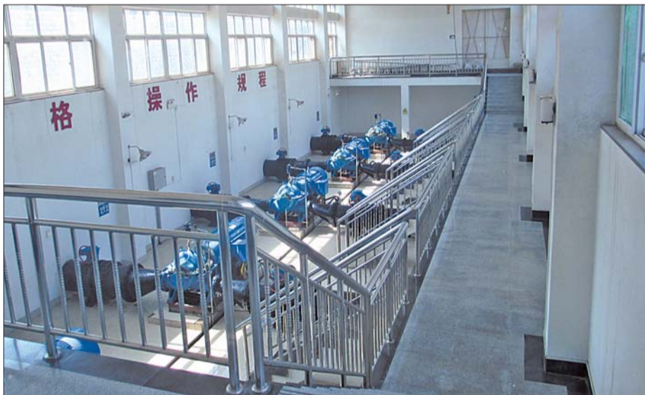
建设路加压站,来自水厂的水正在经此加压送到南部城区。
