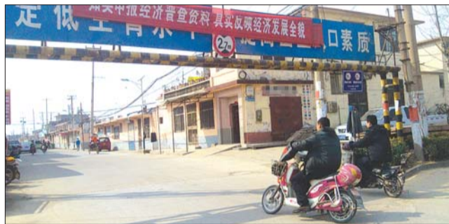
通往村委的一处限高架显示限高2.7米。
