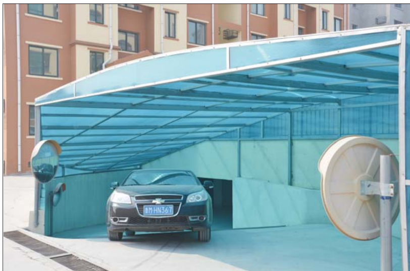
地下车库进出口
