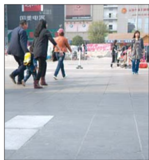
破损的板砖得到更换 本报记者 公素云 摄
