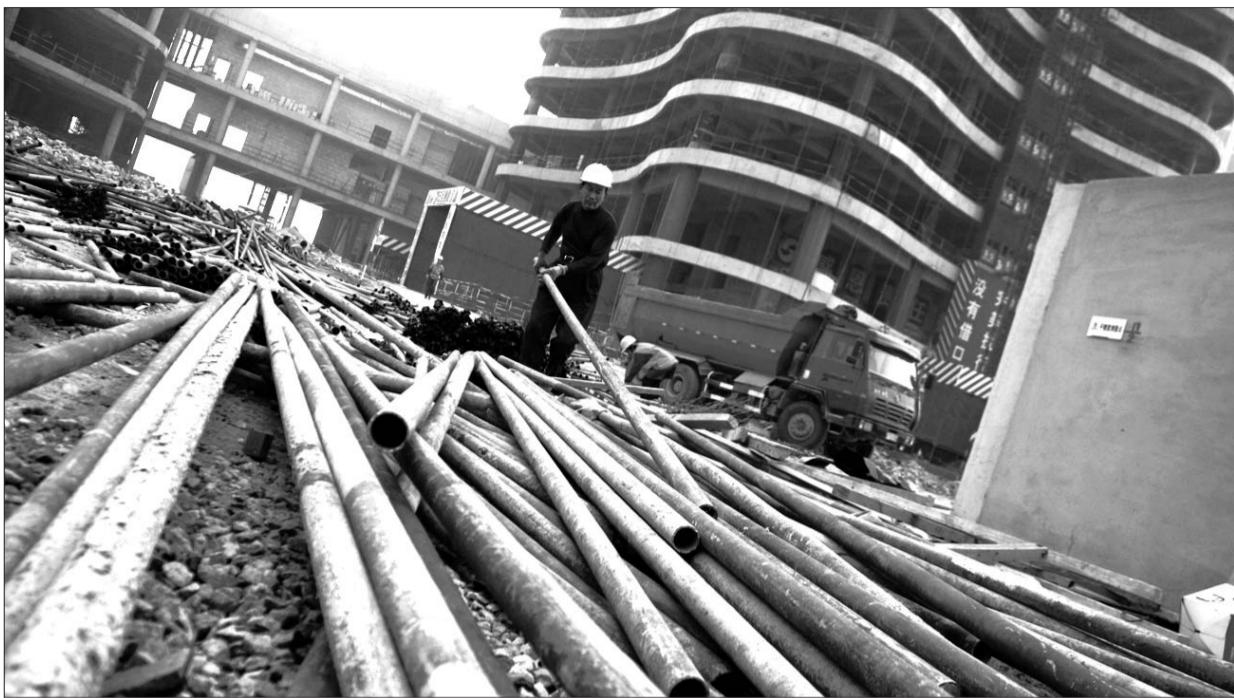
3月27日上午,在东部新区工地上,来自江西的工人宋志杰正在整理拆下来的钢管。 本报记者 王晏坤 摄
