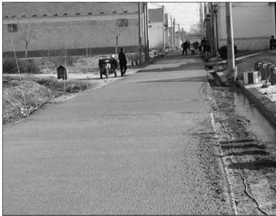
正在铺设的硬化道路。
